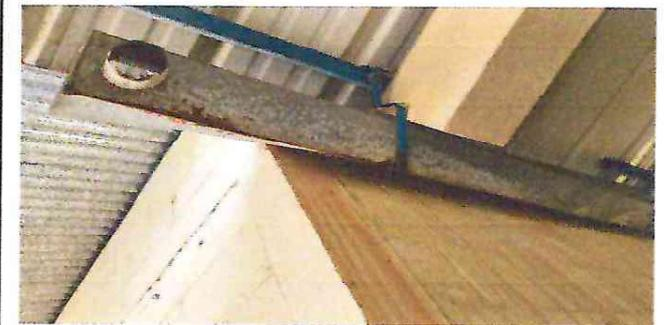
FOTO 4: CANAL DE BAJADA DE AGUA POR EL PASO DE TIEMPO PRESENTA DETERIORO.
