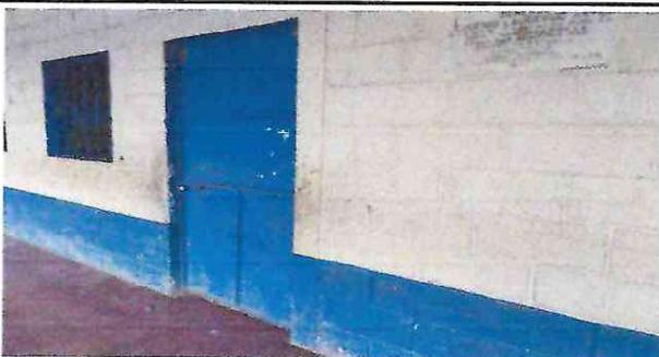
FOTO 5: PAREDES EXTERIORES E INTERIORES SE ENCUENTRAN SUCIAS Y PINTURA DETERIORADA.
