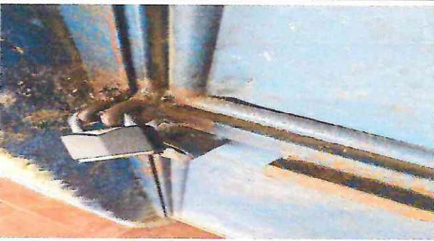
FOTO 3: PUERTAS QUE LA CHAPA NO ESTA EN BUENAS CONDICIONES Y OTRA SE NECESITA SUSTITUIR POR DETERIORO.
